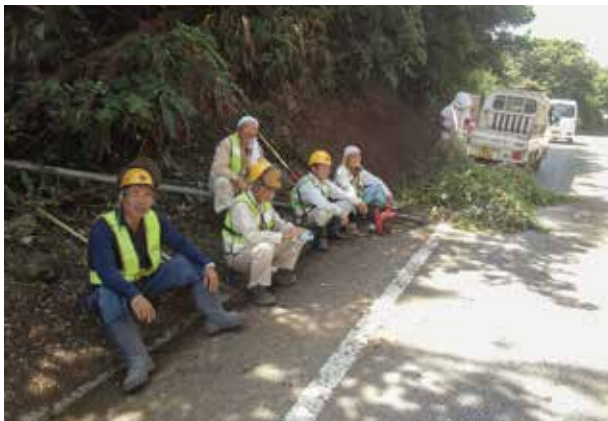
▲県道の除草作業 共働・共助のチーム就業
