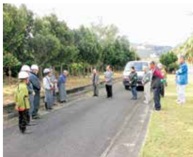
安全対策委員による 作業現場パトロール
