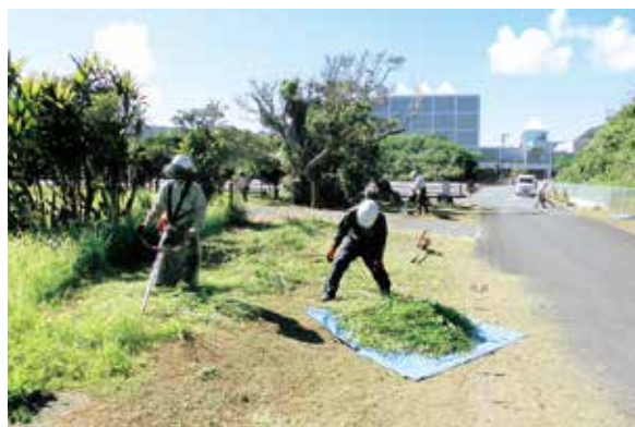
ヘルメット等の安全保護具着用での作業
