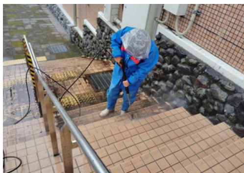
高圧洗浄機による洗浄作業
